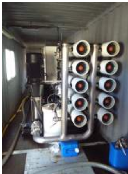
Figura N°2 – Módulo de Ósmosis Inversa a utilizar en la Ampliación.
