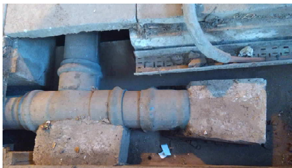
Figura N°5 – Cañería de agua cruda a vincular con Nuevo Módulo de ósmosis inversa.
