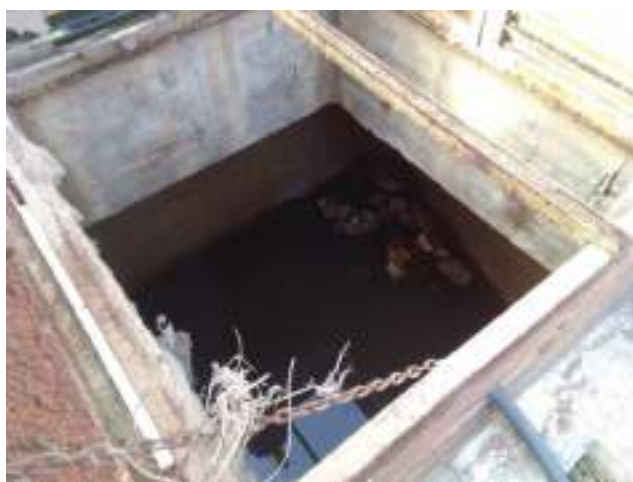
Figura N°7 – Cámara antiguo bombeo a sellar y rellenar.
