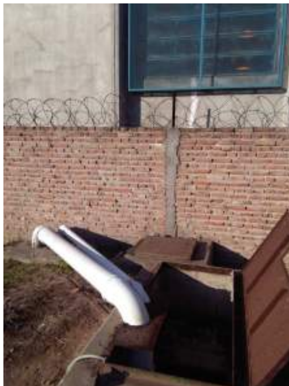
Figura N°4 – Cámara previo ingreso a cisterna a donde conducir el agua osmosada.
