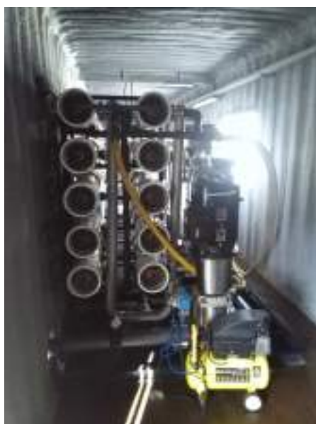
Figura N°2 – Módulo de Ósmosis Inversa a utilizar en la Ampliación.
